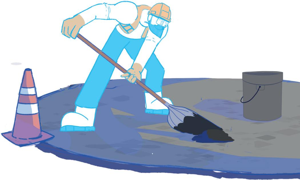
Ahora, antes de colocar las varillas, **debemos esperar a que el diésel con aceite quemado se absorba bien por la madera** para que no se embarre a las varillas mientras las colocamos. De lo contrario, se corre el riesgo de que haya poca adherencia entre las varillas y el concreto.
